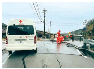
壊れた道路の段差を埋める救護班要員
